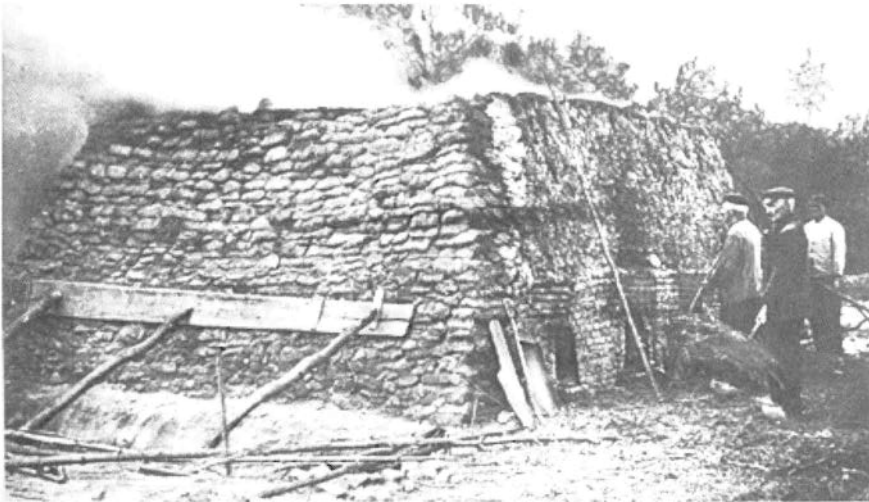
Abb. 4: Feldbrand bei Vreden, 1927. Deutlich sichtbar sind Holzstützen, die eine einsturzgefährdete Ofenwand sichern.
