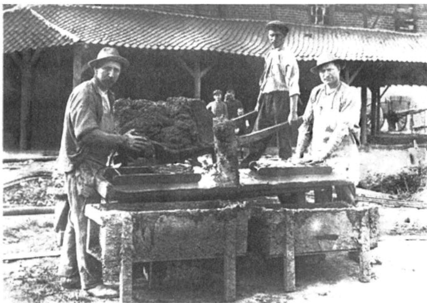
Abb. 9: Ziegelstreicher bei der Arbeit
