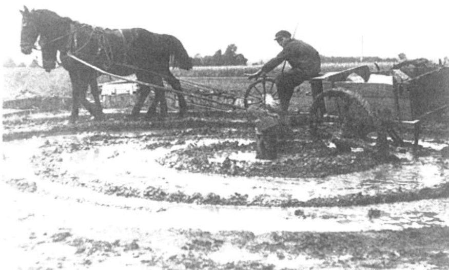
Abb. 8: Lehmaufbereitung mit Pferdekraft
