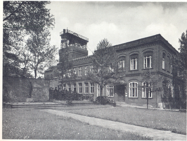
Die Hauptverwaltung mit Schacht 1
