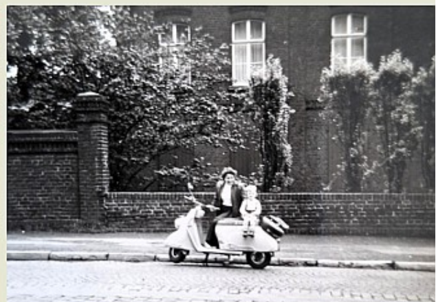
Haupthaus und Einfriedungsmauer 1956. Im Vordergrund die Josephinenstraße.
