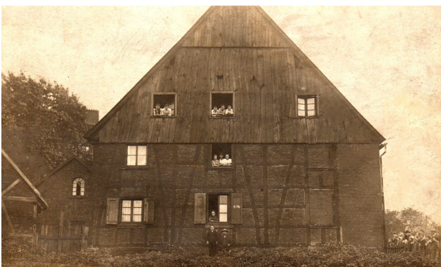
Der Tenthof vom Constantinteech aus gesehen. Links im Hintergrund das Dach des Hauses Josephinstraße 23. (Foto: unbekannt)
