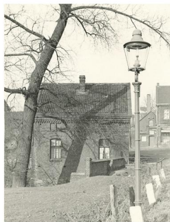
Blick von Süden 1936. Im Hintergrund die ehem. Bäckerei Lueg (Prattwinkel 1) (Foto: Wörzberger)
